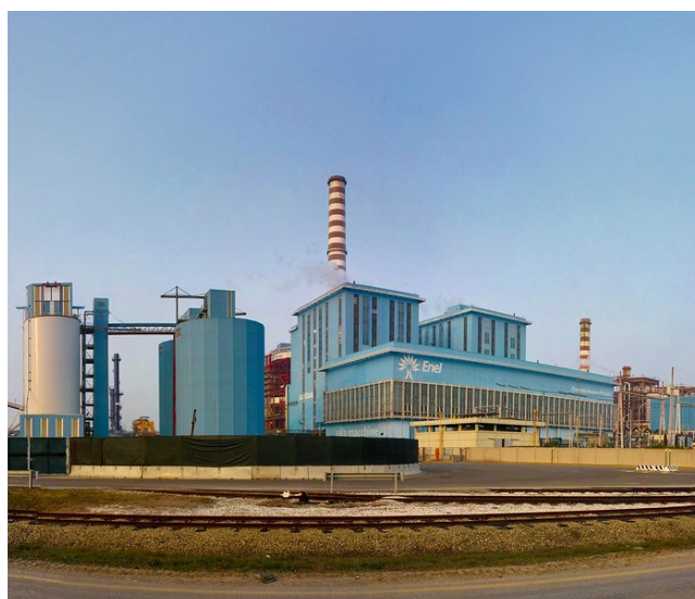
Centrale termoelettrica di Fusina. Foto iLenny, Flickr, CC BY-NC-SA 2.0
